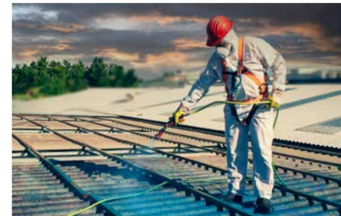
Bonifica mediante incapsulamento conservativo delle coperture in cemento amianto
