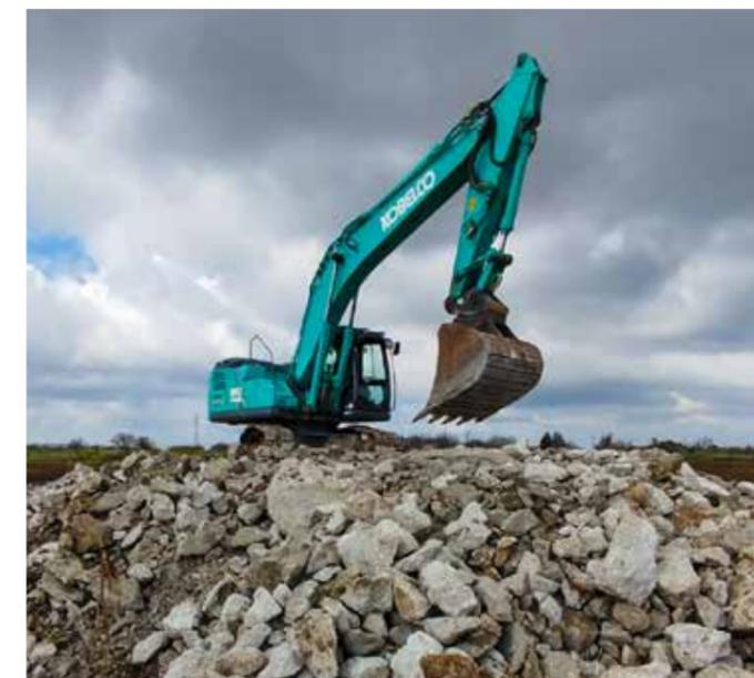
Comune di Melissano (LE), lavori di demolizione platee di fondazione ex impianto fotovoltaico
