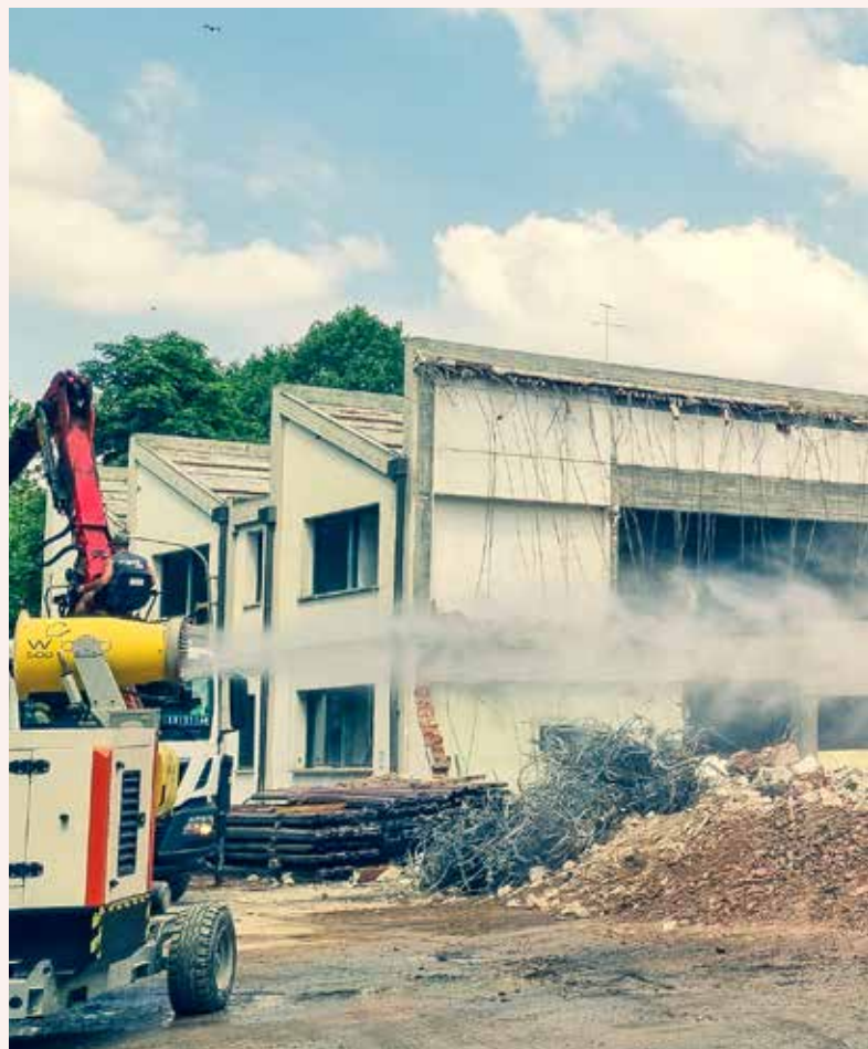
Foto Serveco: demolizione di edificio a Bologna
