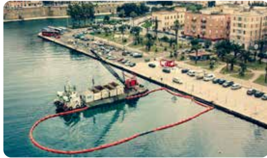
Rimozione dei materiali di natura antropica dal fondale del Mar Piccolo a Taranto
