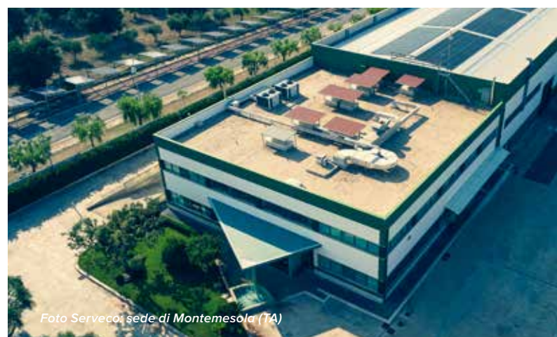
Foto Serveco: impianto di Specchia Tarantina a Martina Franca (TA)
